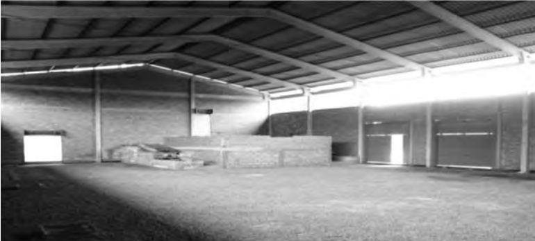
Galpão da Coopetsinos – Novo Hamburgo
